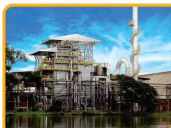
ALGAR AGRO - Uberlândia - MG Caldeira EV-2-1000; 40 ton/h; 13 kgf/cm²; 196 °C (1ª Fase) Caldeira EV-2-1000; 55 ton/h; 66 kgf/cm²; 495 °C (2ª Fase)
