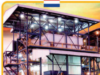
INPASA - Nueva Esperanza - PY Caldeira EV-2-2500; 100 ton/h; 25 kgf/cm²; 330 °C
