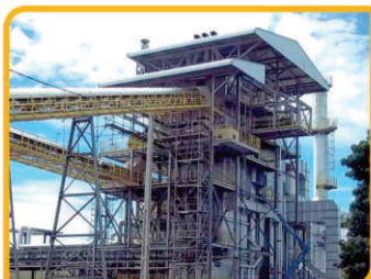
CARGILL AGRÍCOLA S/A - Três Lagoas - MS Caldeira EV-2-1000; 40 ton/h; 65 kgf/cm²; 490 °C
