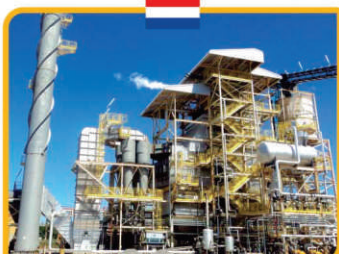
ADM PARAGUAY S.R.L. - Asunción - PY Caldeira EV-2-2000; 80 ton/h; 16 kgf/cm²; 203 °C
